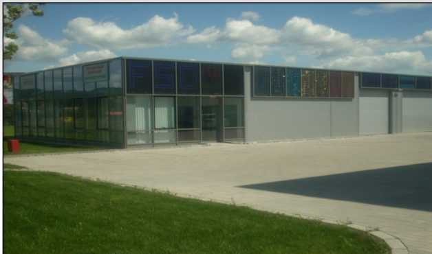
4kW FSD Reenergy
